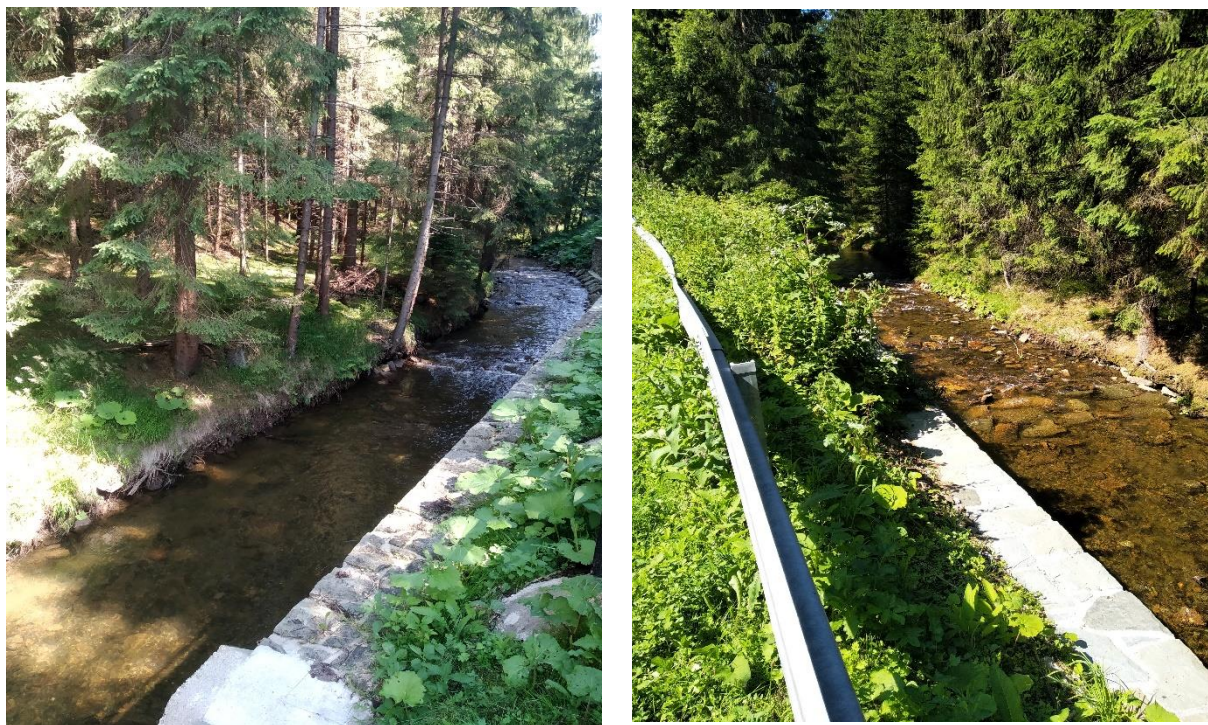
Obrázek 17 - Rekonstrukce kamenné opěrné zdi podél toku Černá Ostravice – Biskupství ostravsko-opavské
