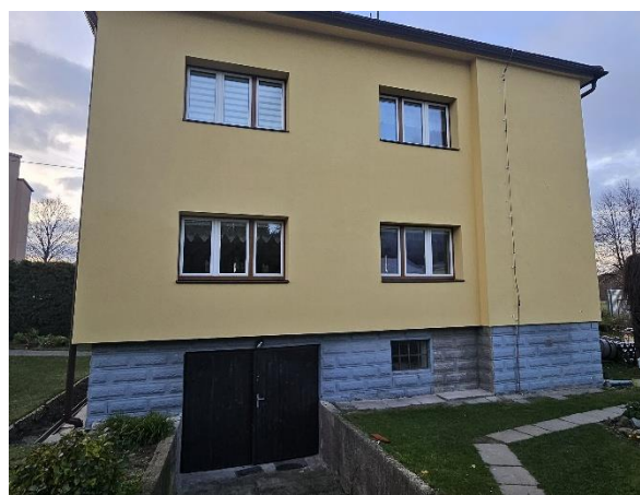
Obrázek 24: Rekonstrukce fasády v NZÚL – stav po realizaci
