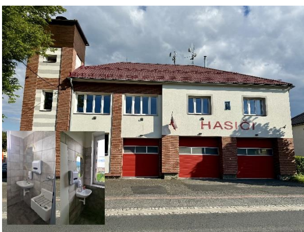
Obrázek 10: Rekonstrukce hygienického zázemí požární zbrojnice Čeladná
