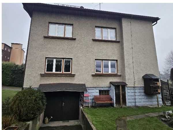
Obrázek 25: Rekonstrukce fasády v NZÚL – stav před realizací
